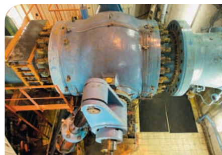
Usine B3, robinet sphérique vu du dessus, STEP de Super Bissorte.
